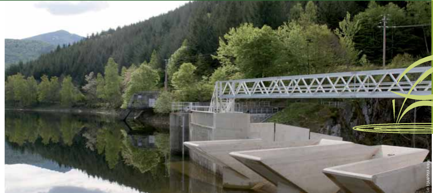
Barrage de Goulours en Ariège.
